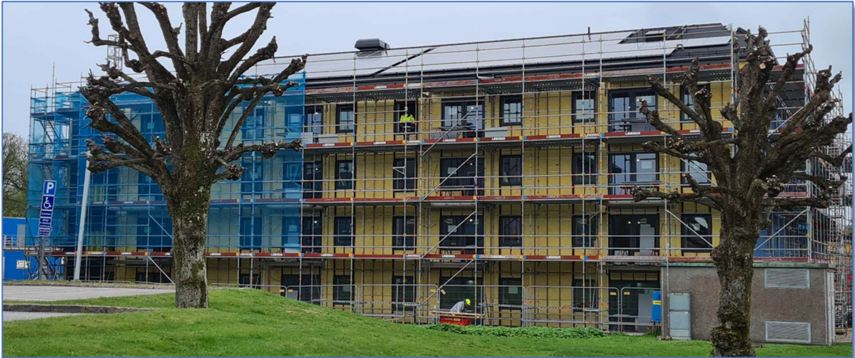
Uddevallahems nya hus på Strömstadsvägen, ett föredöme med taket täckt av solceller.
