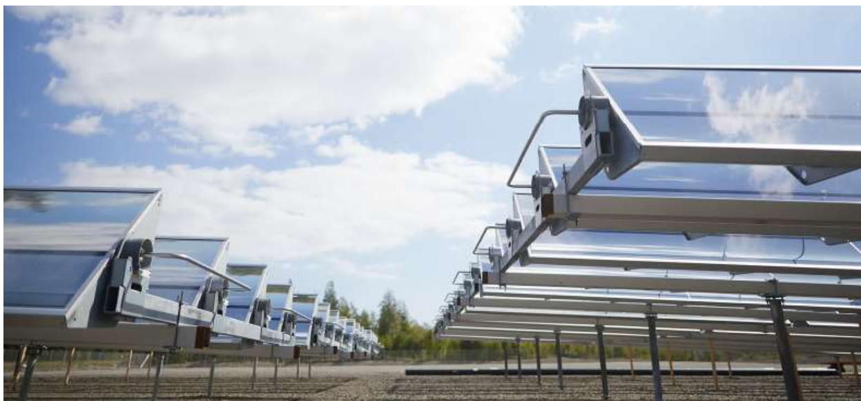
Koncentrerande solfångare i Högslätten Solar Thermal Park som matar in hetvatten på fjärrvärmenätet i Härnösand
