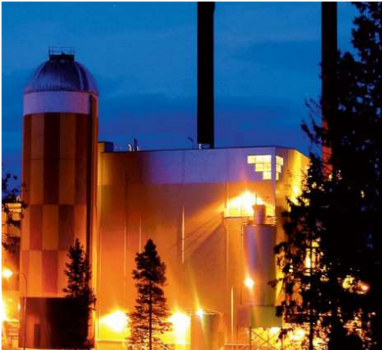
Härnösands kraftvärmeverk eldar flis och pellets, men också har en stor elpanna och får spillvärme från pelletsfabriken Bionorr.
